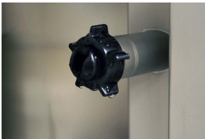
Abbildung 55: Einbau neuer Düsen. Nicht zu fest anziehen!
