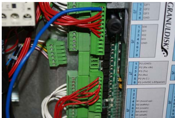
Anschluss J7, Bedienpult getrennt.
